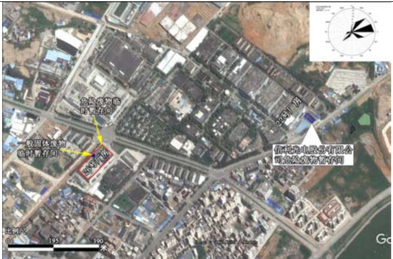
图 3-5 信利光电股份有限公司固体废物暂存间
