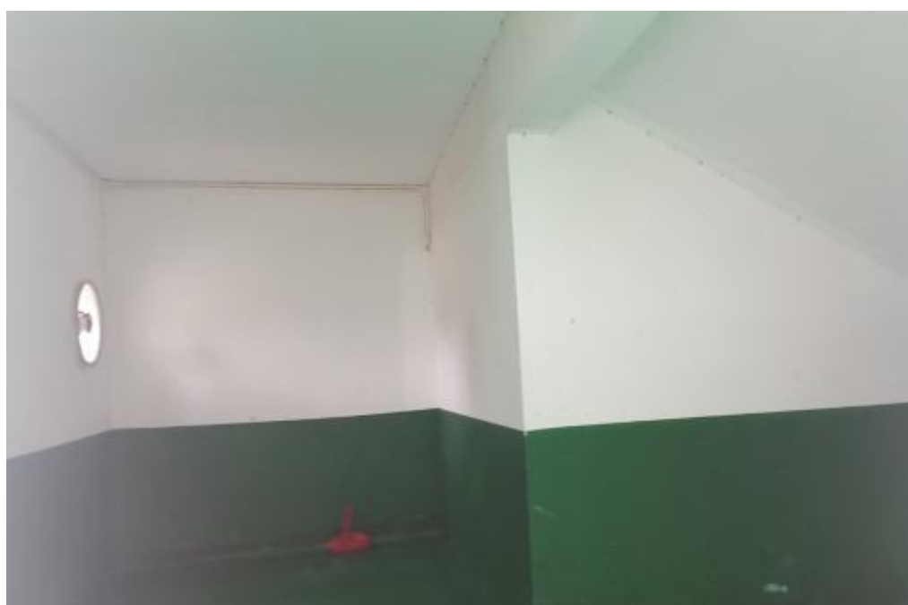
26 号厂房危废临时储存场所
